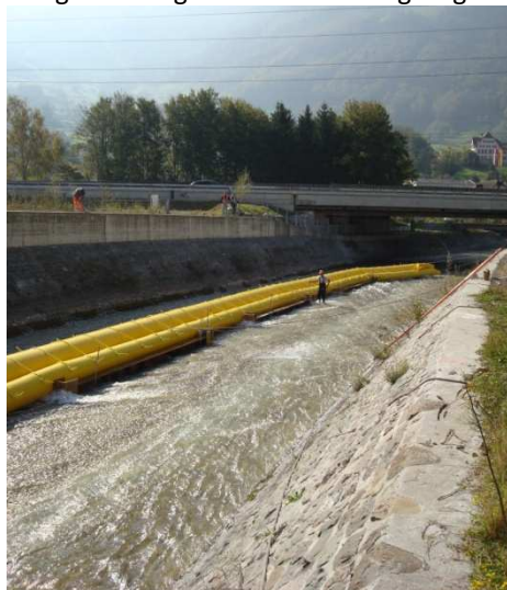
Die Schläuche werden in die richtige Position eingeschwommen.
