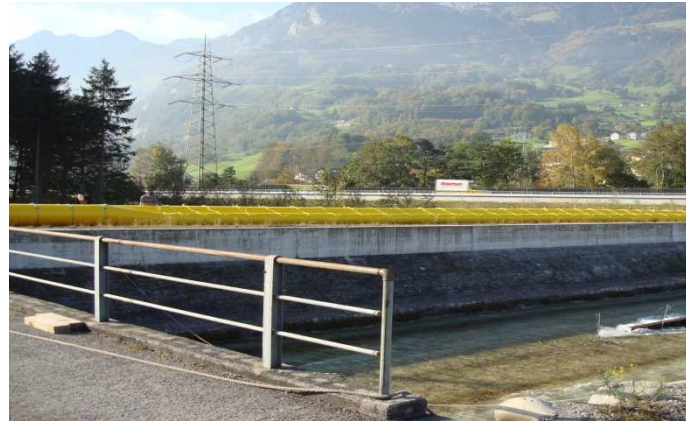
Die mit Luft gefüllten Schläuche liegen auf der Dammkrone und sind bereit, um auf das Wasser gelassen zu werden.
