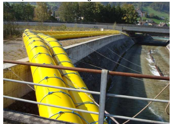
Der Einbau erfolgt ohne Einsatz von Maschinen. Total sind nur 5 Mann im Einsatz.
