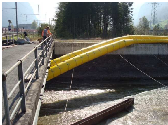
Die oberen Schlauchenden werden heruntergelassen und gleichzeitig unter die Brücke gezogen.
