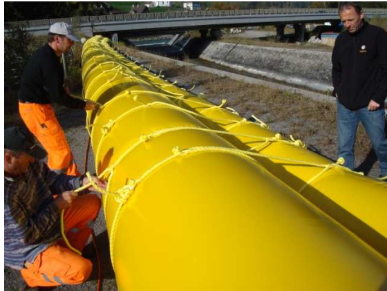
Die beiden Schläuche werden mit vorgefertigten Seilen miteinander verbunden.
